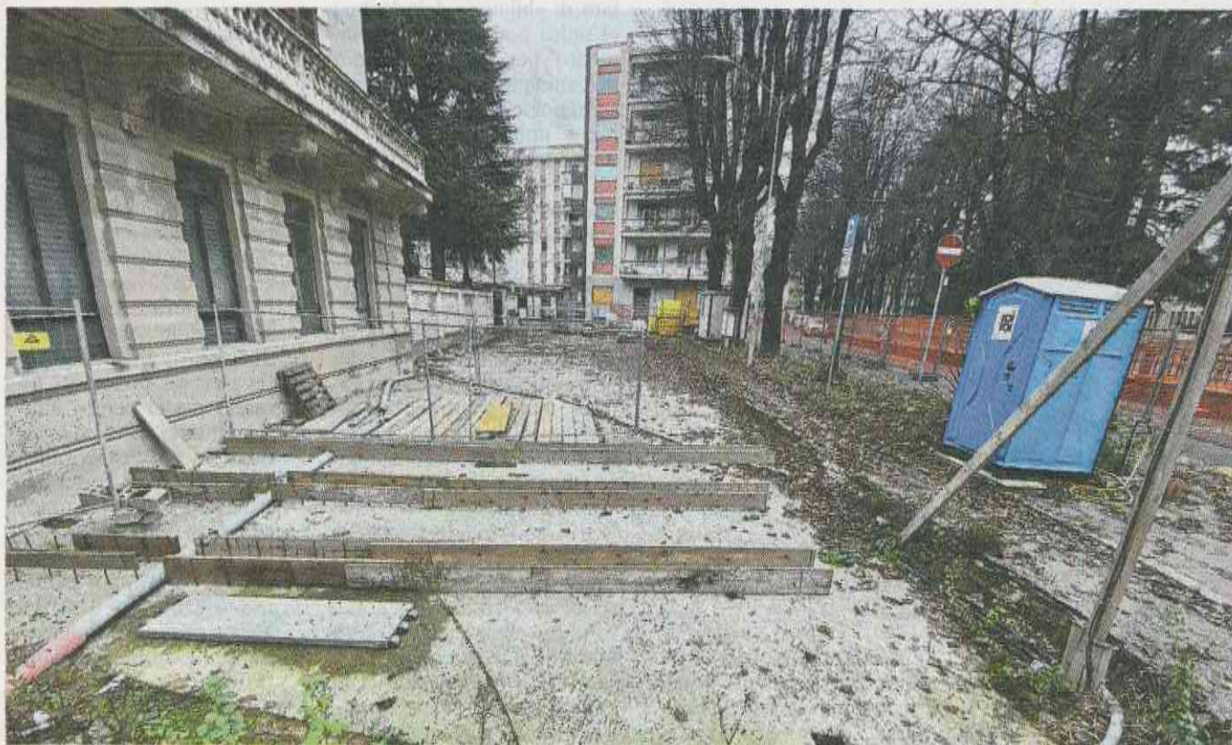
Il cantiere del naviglio Sforzesco in piazza Vittorio Veneto, di fronte ai giardini delle elementari Regina Margherita
